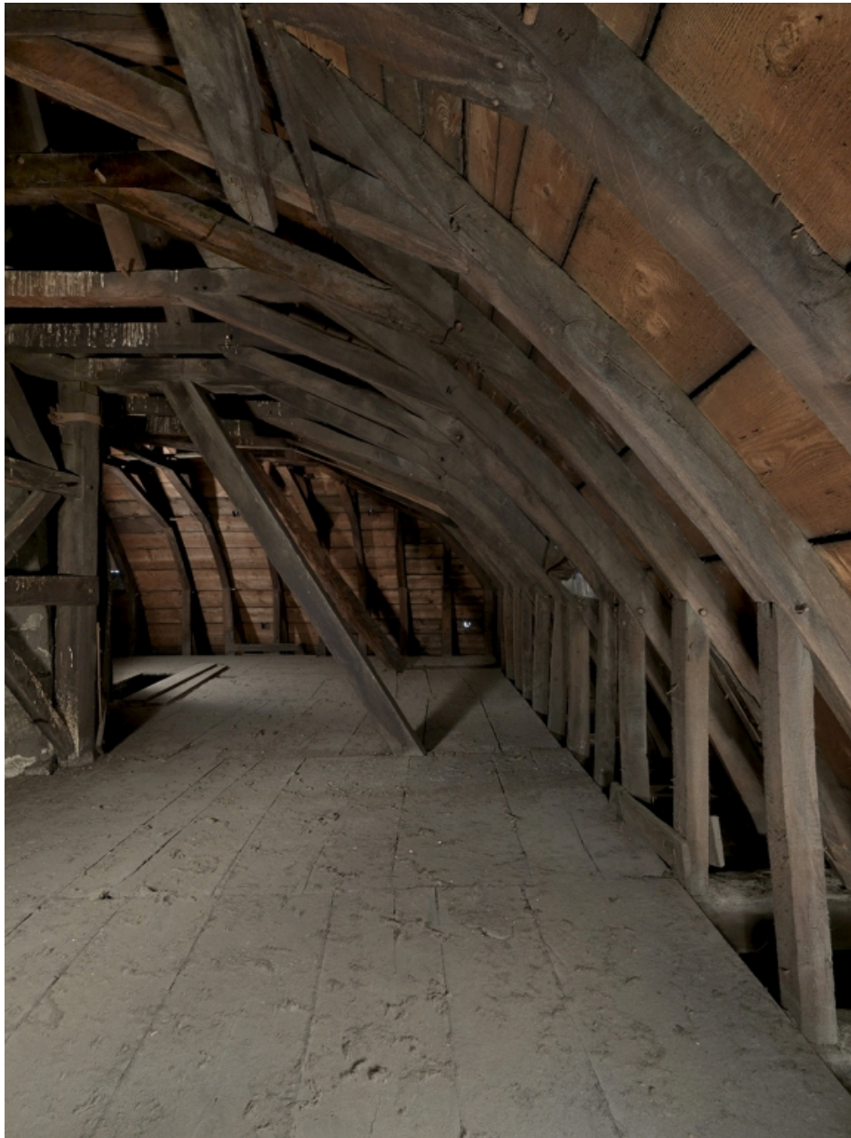
Le dôme des Quatre Rangs. 3e niveau de charpente. Vue d'ensemble du côté sud
