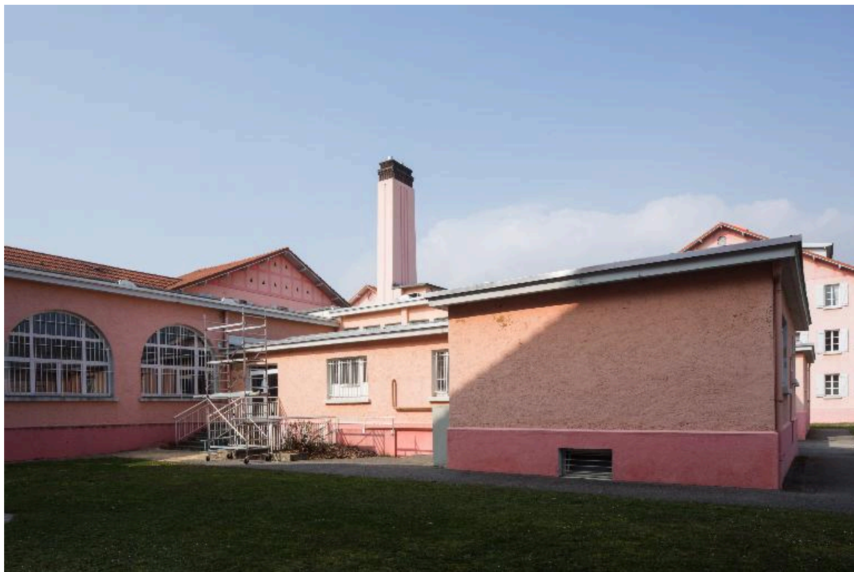
Bât. A : pavillon central vu depuis le nord
