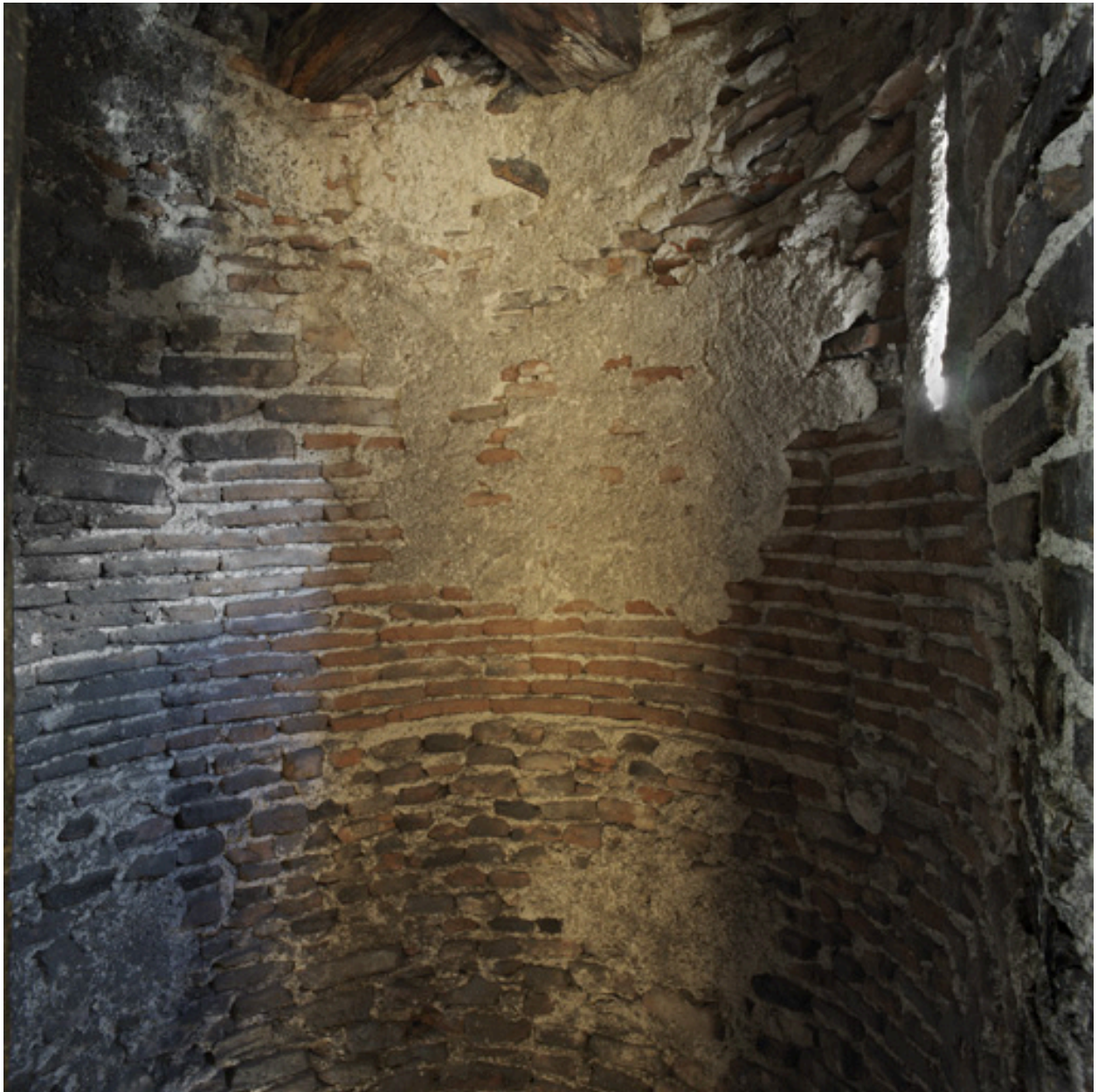
Intérieur de l'échauguette : construction en brique visible dans l'étage en surcroît.
