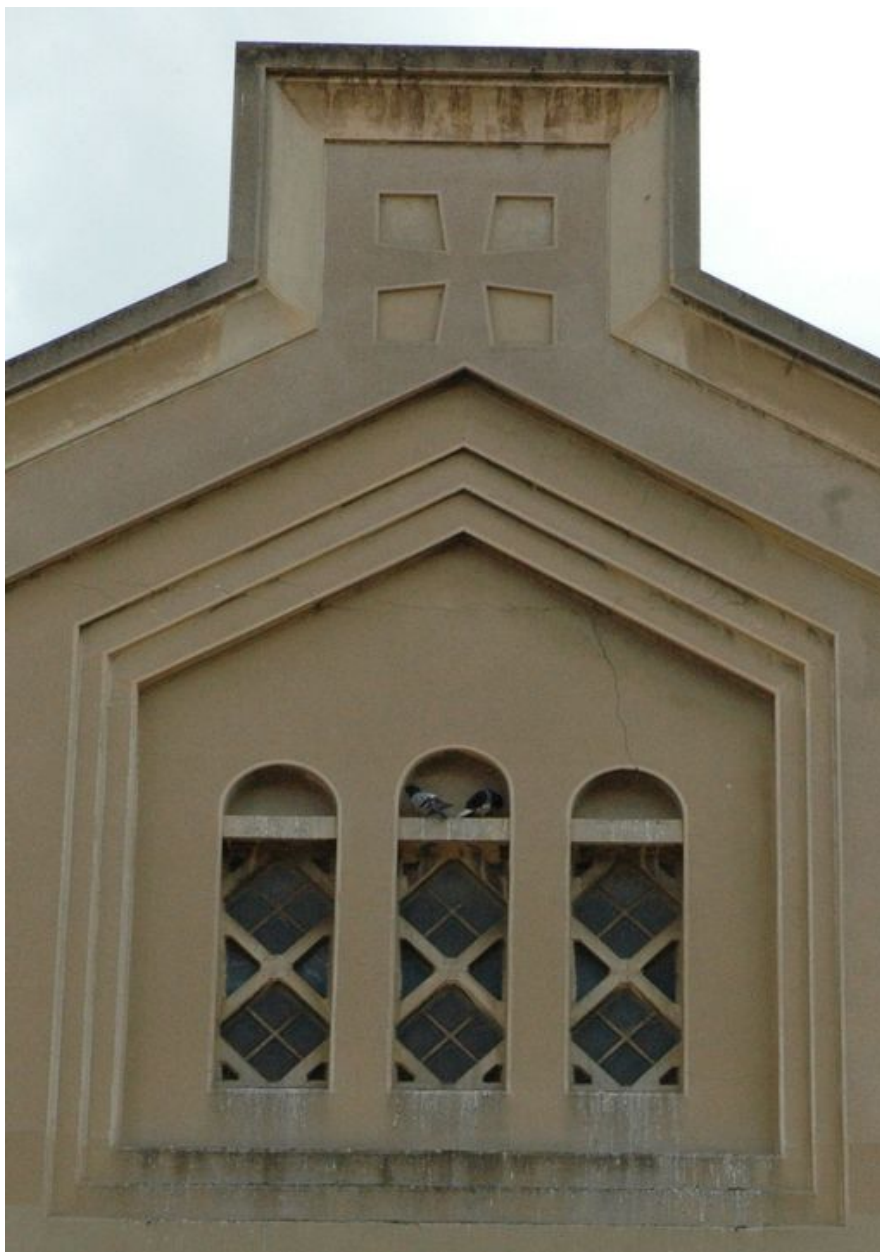
Façade nord : détail des baies et du fronton du transept
