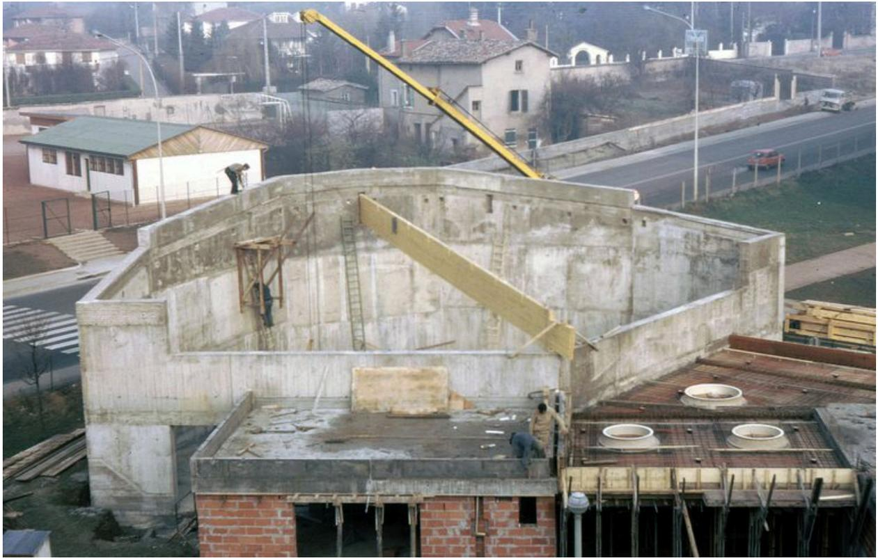
Pose de la première poutre en lamellé-collé
