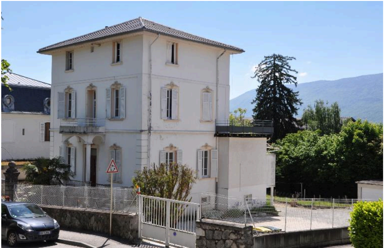
Vue de trois-quart depuis le nord-est
