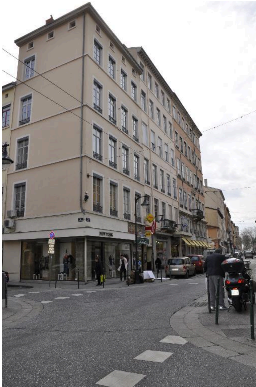
Vue d'ensemble nord ouest de l'immeuble de 5 étages
