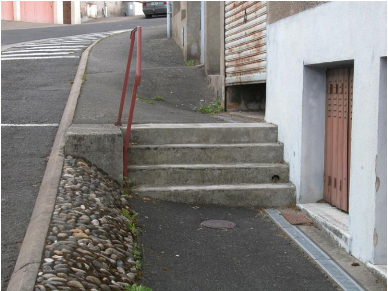
Emmarchements d'un trottoir de la rue, aménagé pour la pente (photographie chercheur).
