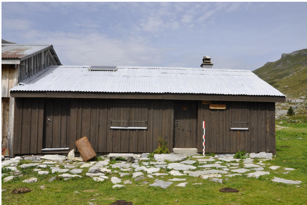
Vue de la façade antérieure sud
