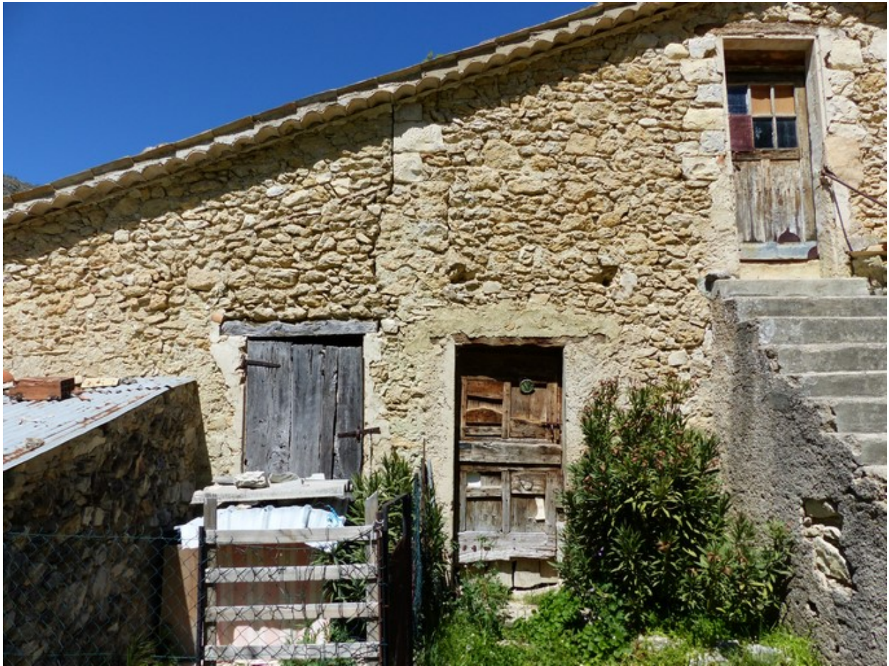
Pignon sud, collage de maçonnerie et surélévation de la partie ouest.
