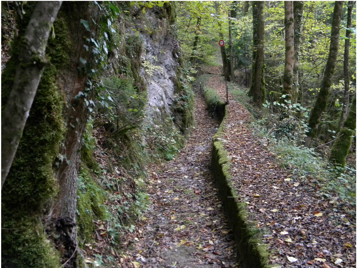
Vue du bief à sec.
