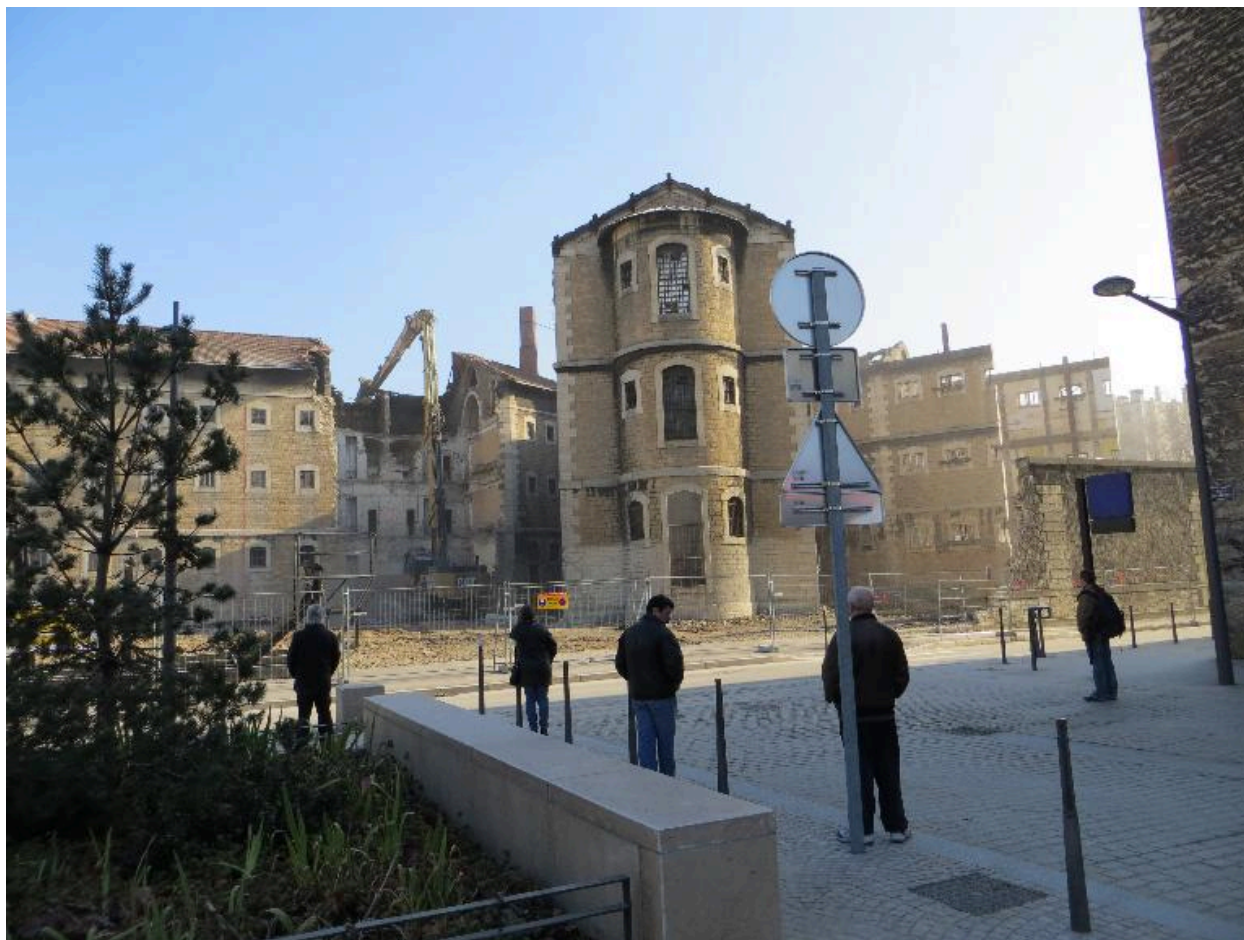
Etat au 19 février 2013 : ailes sud-ouest et nord-ouest, déconstruction partielle de l'aile nord
