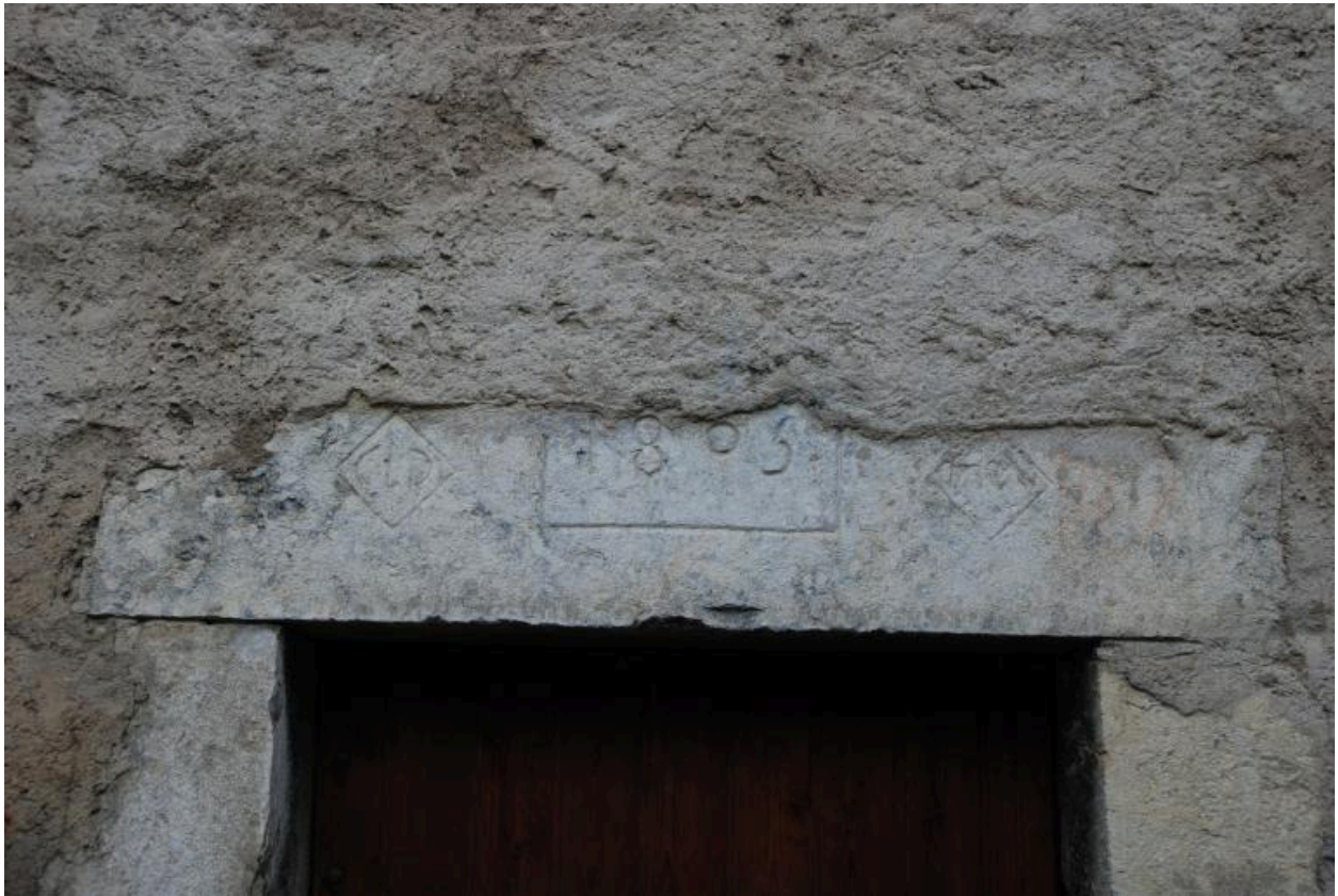
Maison, élévation principale : détail du linteau de la porte de la cave, daté 1805.
