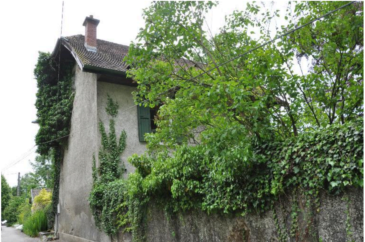
Vue de trois-quart depuis le nord-est
