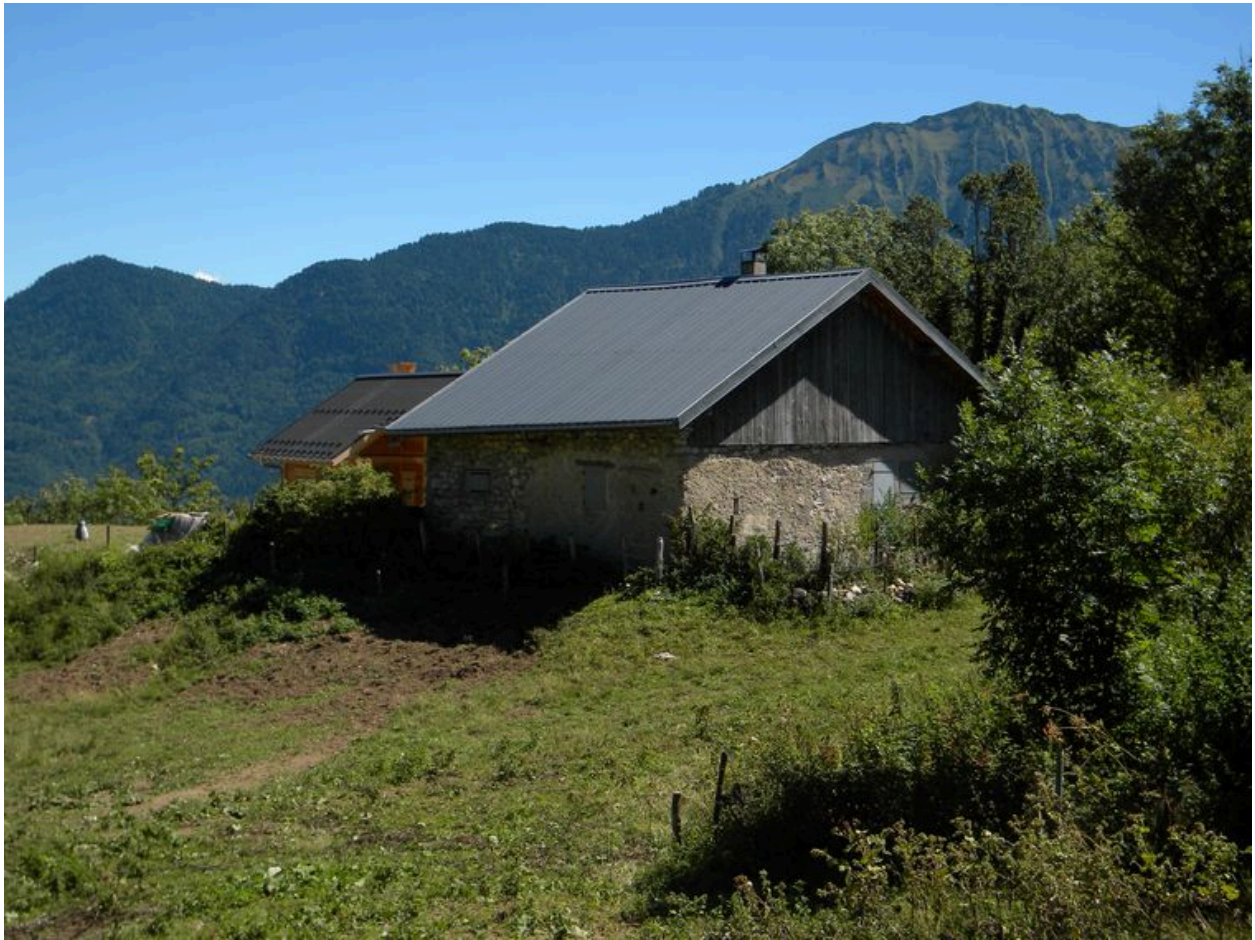
Vue des façades arrières d'une ancienne grange au coeur du hameau
