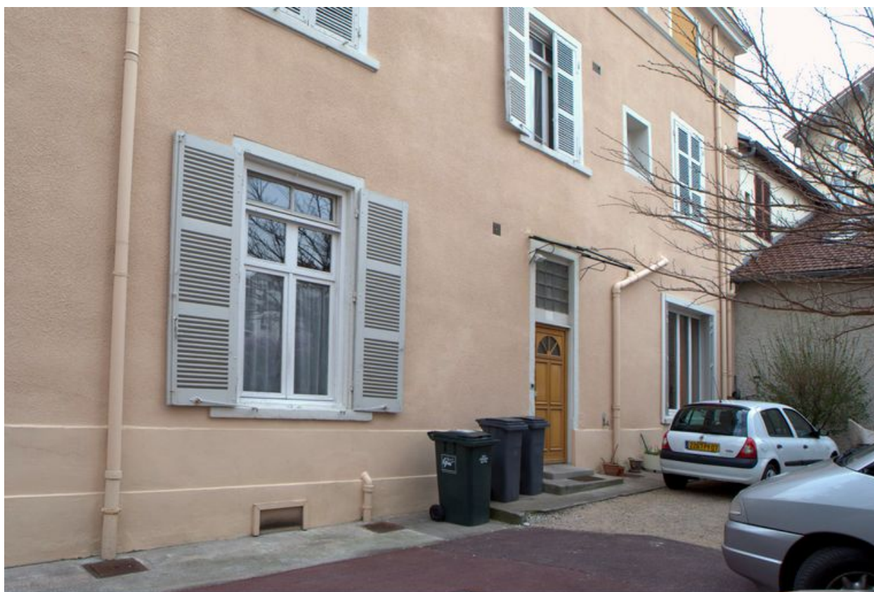
Elévation postérieure, vue partielle
