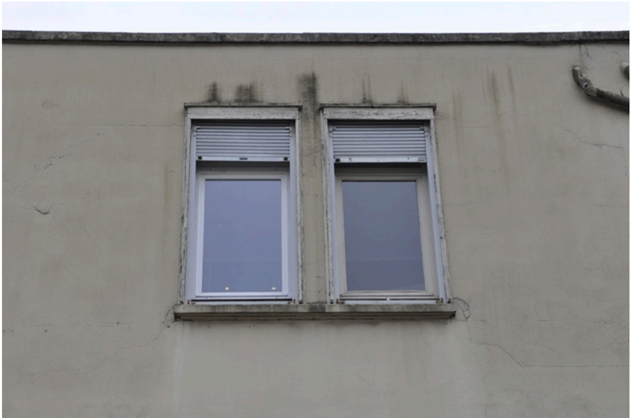
Détail baie façade ouest
