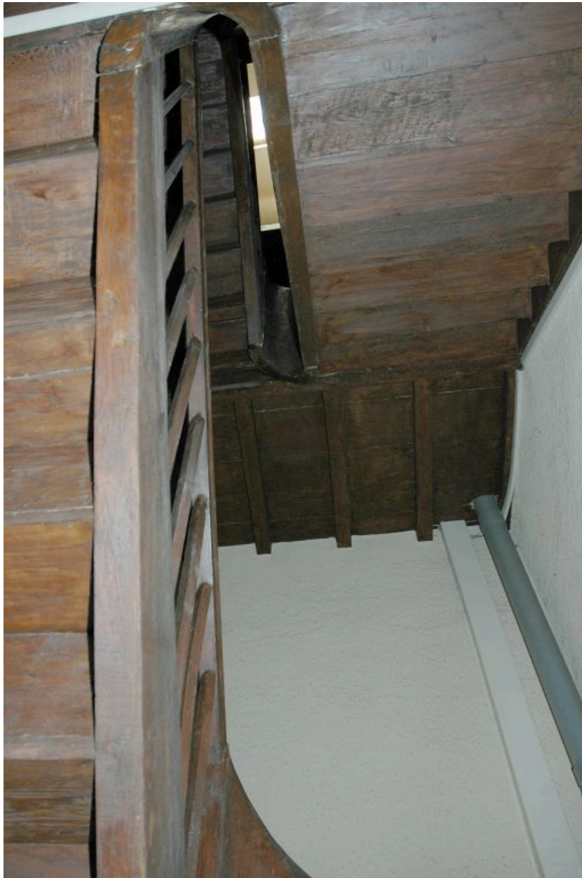
Vue partielle des volées d'escalier, du bas vers le haut.
