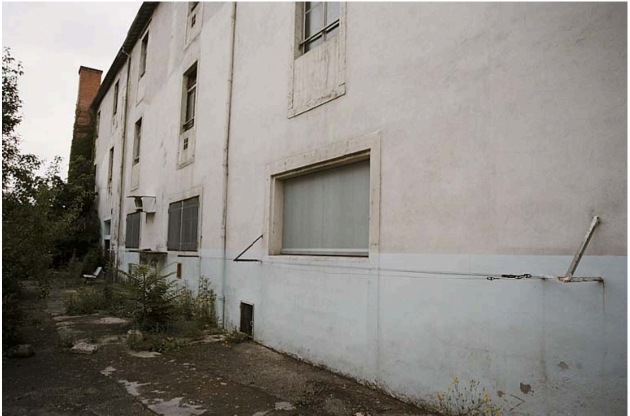
Façade est du bâtiment principal
