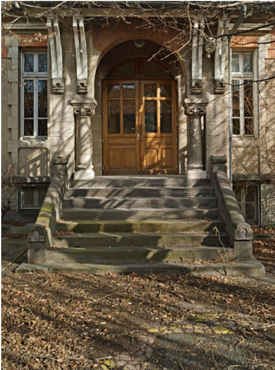
Hôtel-Dieu de Clermont-Ferrand. L'hôpital pour enfants, pavillon Tixier, entrée principale (au centre de la façade ouest).
