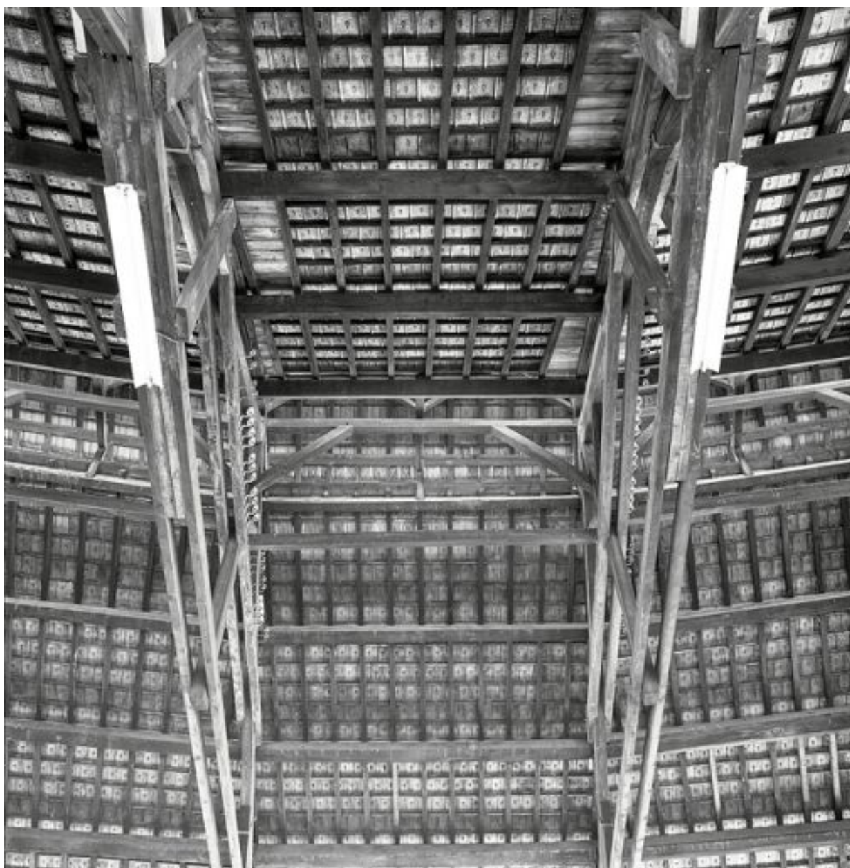
Vue de la charpente
