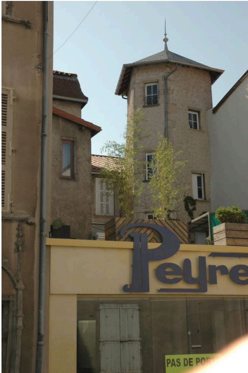
Vue partielle de l'escalier en vis demi-hors-oeuvre.
