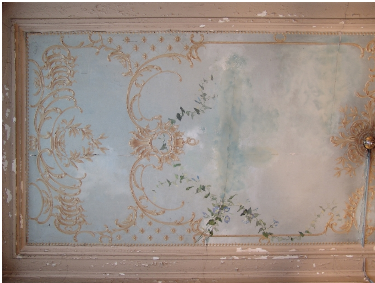
Plafond du hall
