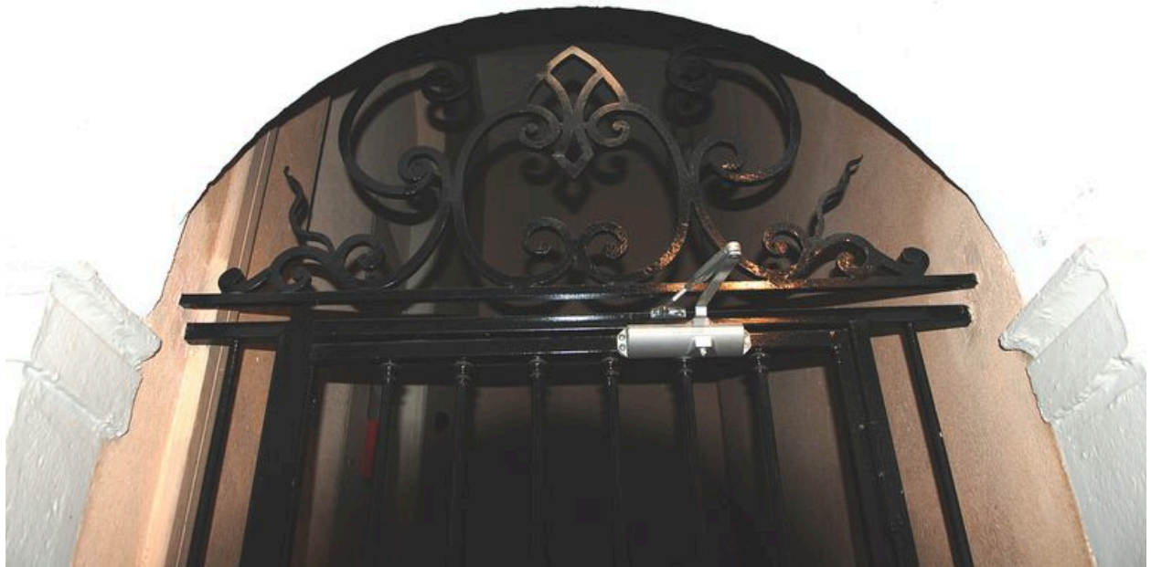
L'allée : détail d'une des grilles fermant l'accès à l'escalier
