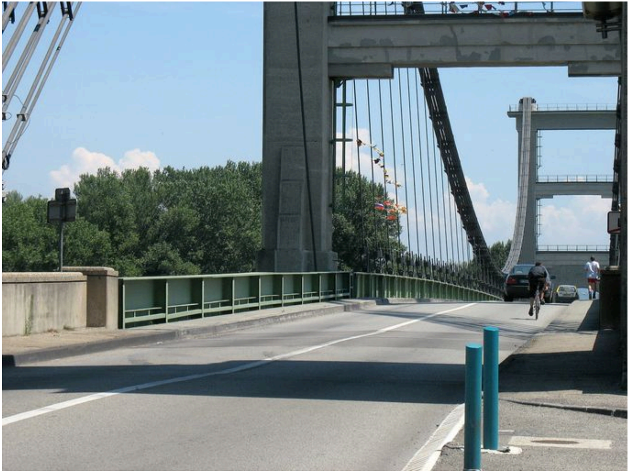
Vue de la chaussée
