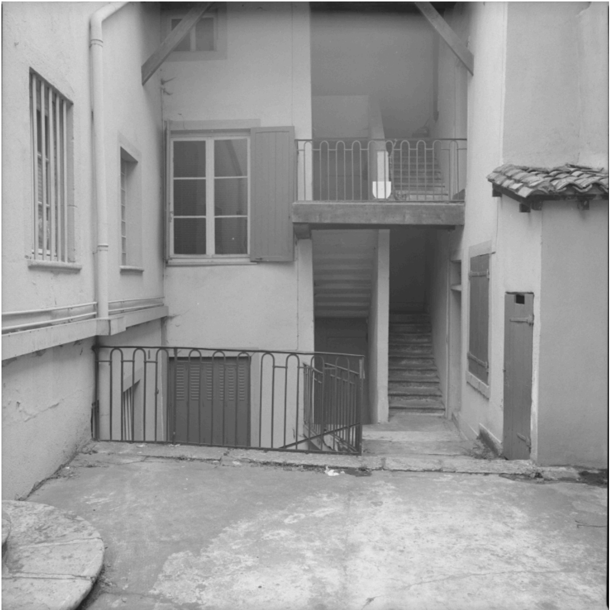
Escalier à cage ouverte sur cour, immeuble 26 Grande rue, parcelle traversante sur rue Montsec.
