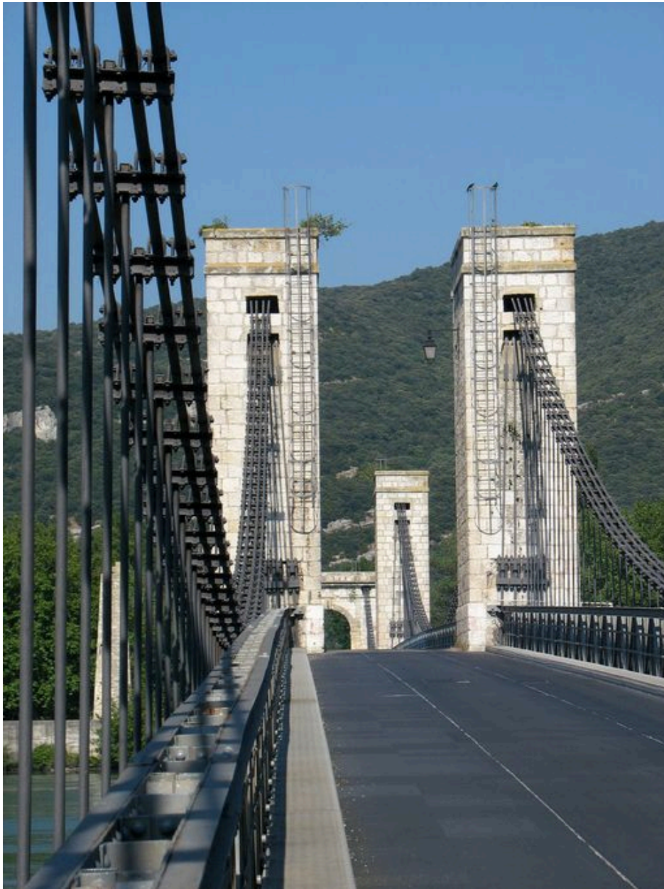
Sur le tablier, vue vers l'ouest
