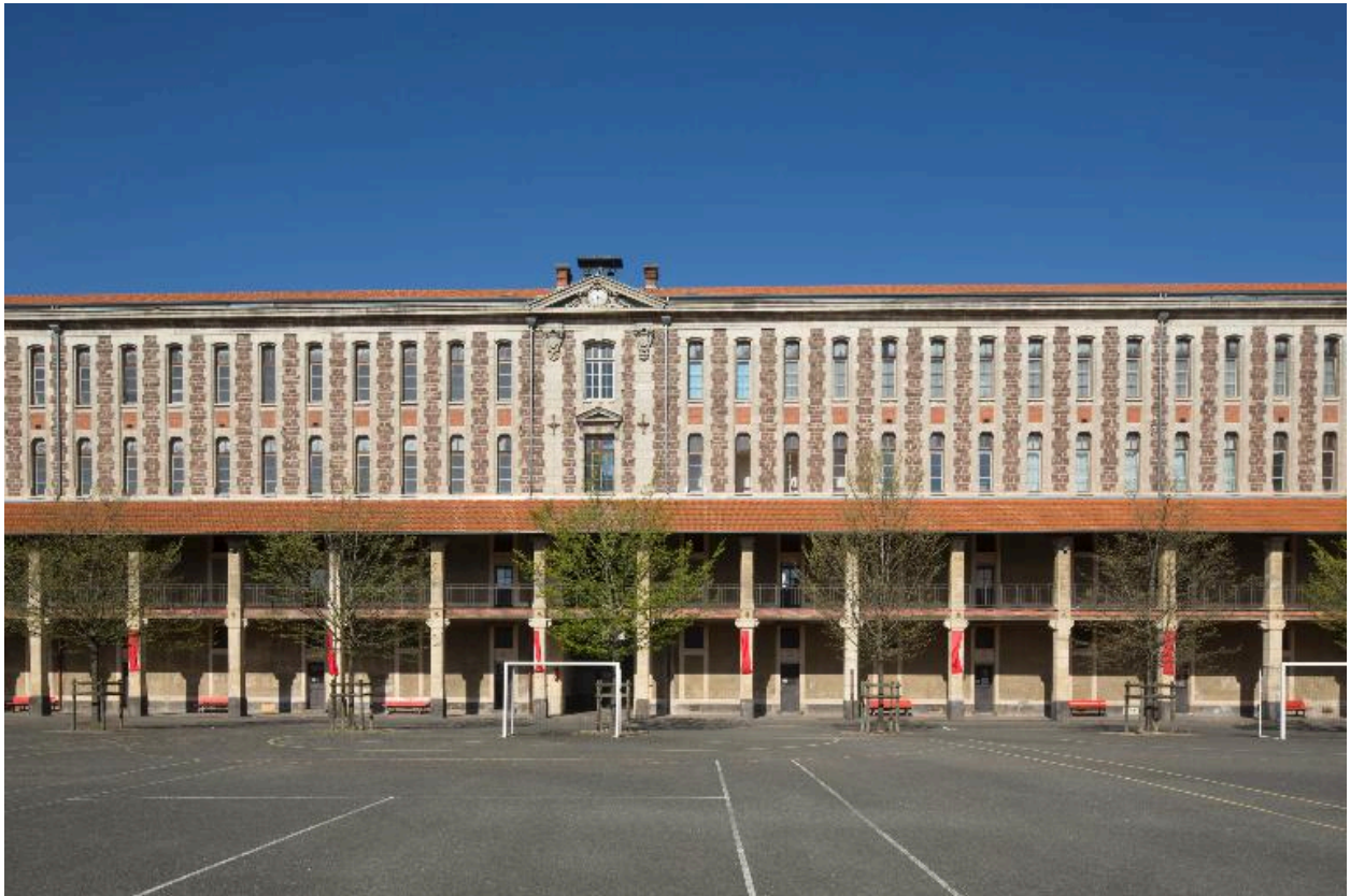
Bâtiment A. Façade sur cour, vue rapprochée
