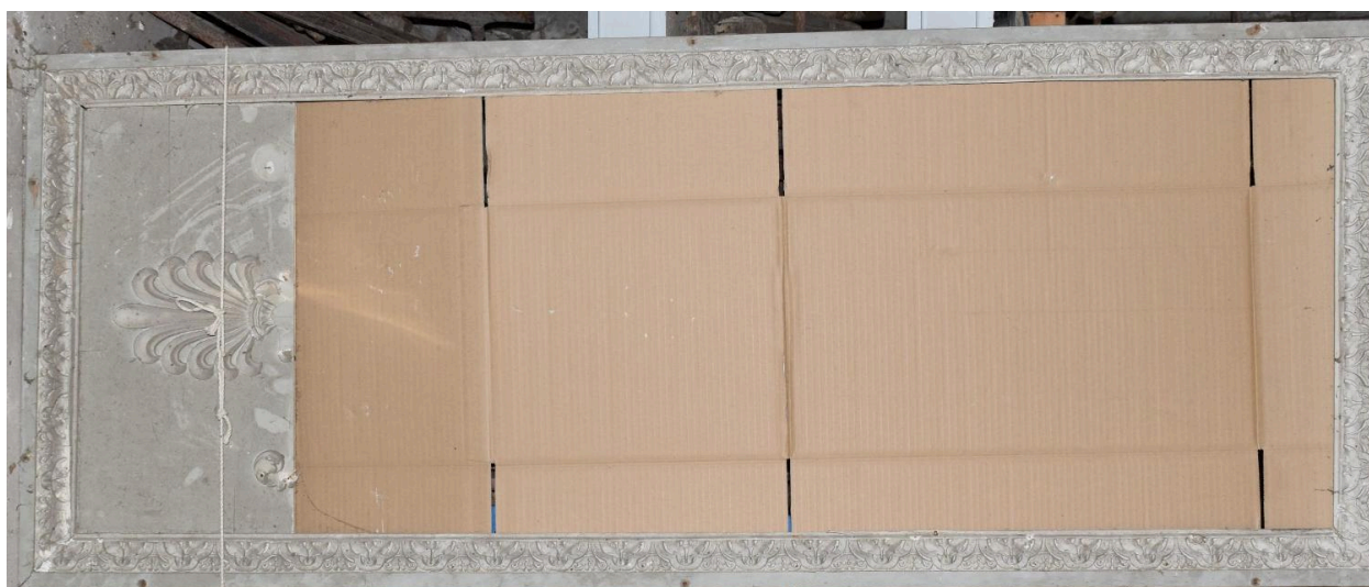
Vue générale - panneau 4
