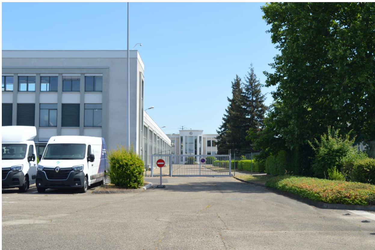
Entrée de l'ancienne usine S.I.G.M.A. et bâtiment de l'administration - vue depuis le Boulevard Irène Joliot Curie -
