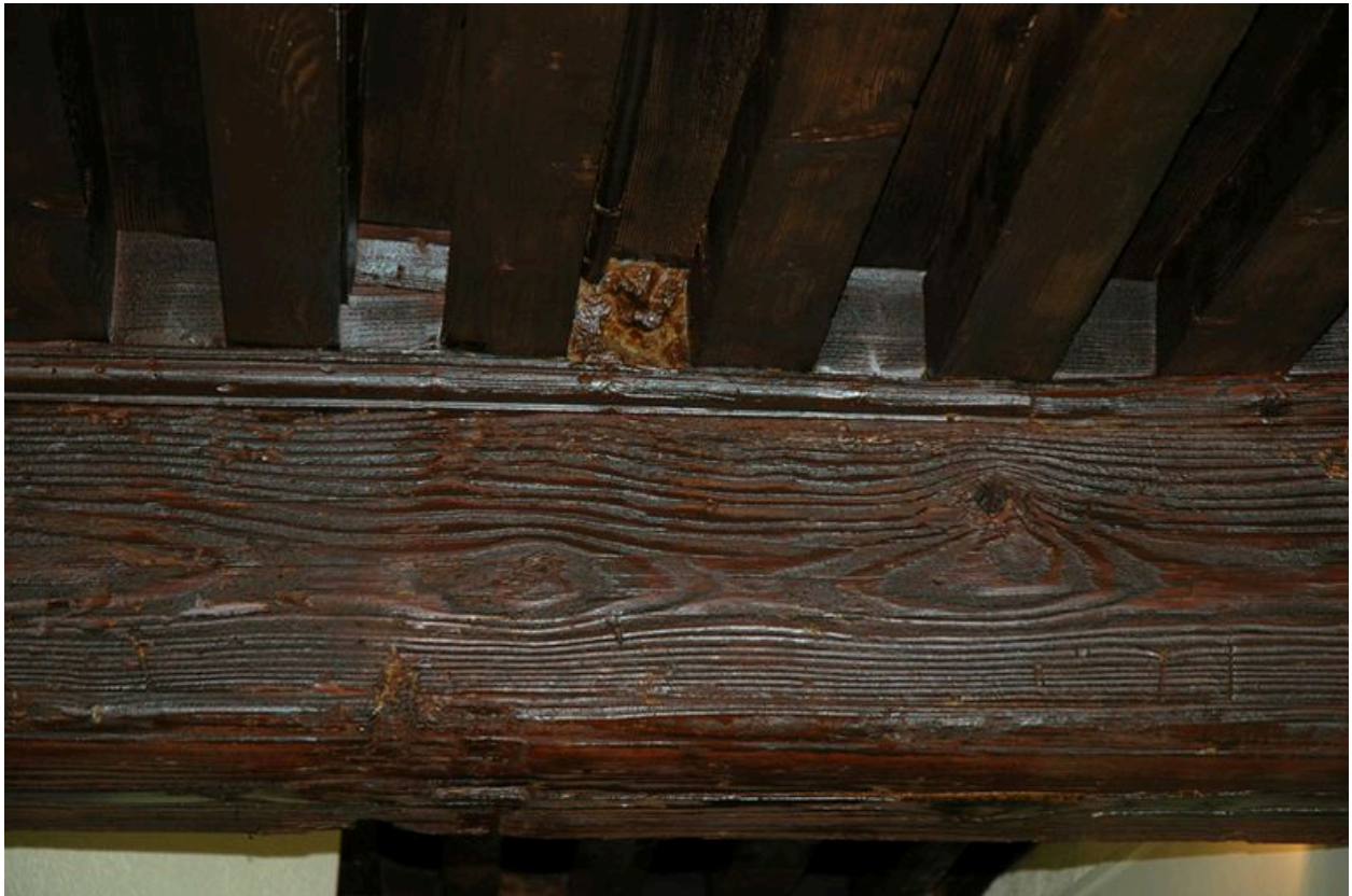
Détail du plafond à solives du vestibule
