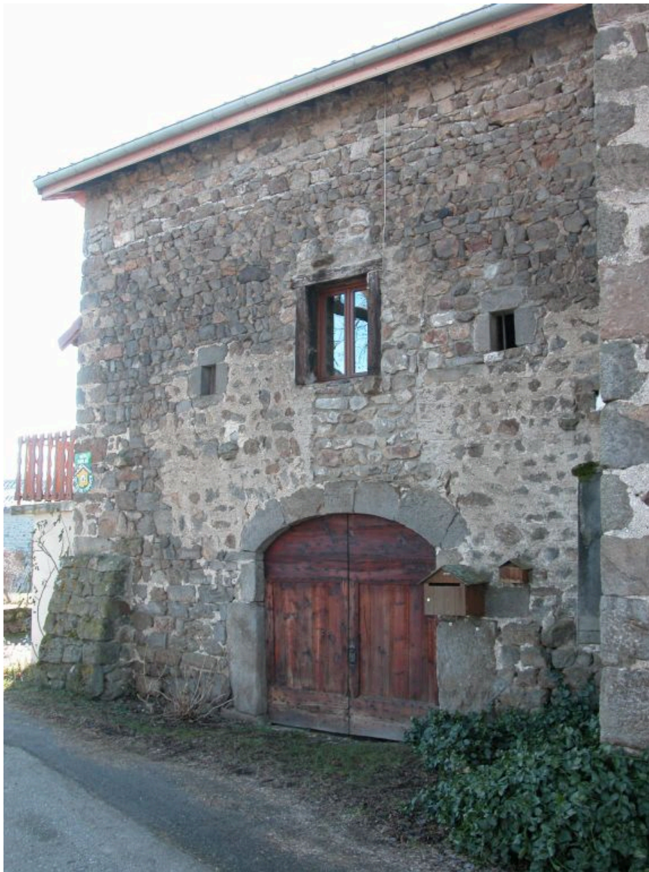
Vue arrière du logias ancien à aître avec portail du passage couvert.
