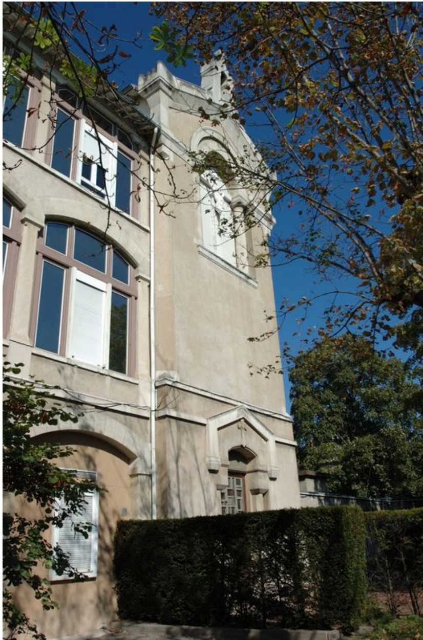
Détail de la chapelle, depuis la cour, côté Radisson (élévation est), en octobre 2011.
