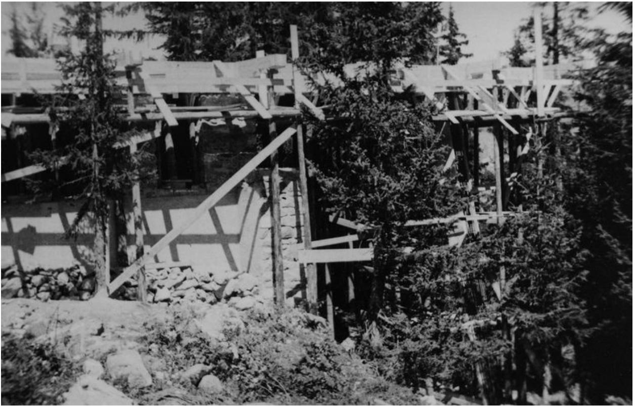
Le chalet en construction. Photogr. Denys Pradelle, [1950] (AD Savoie. 6J 100)
