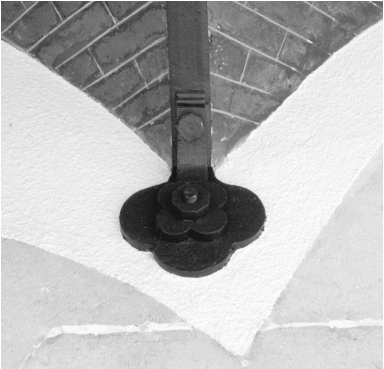
Galerie est du cloître, détail d'une attache maintenant les doubleaux métalliques
