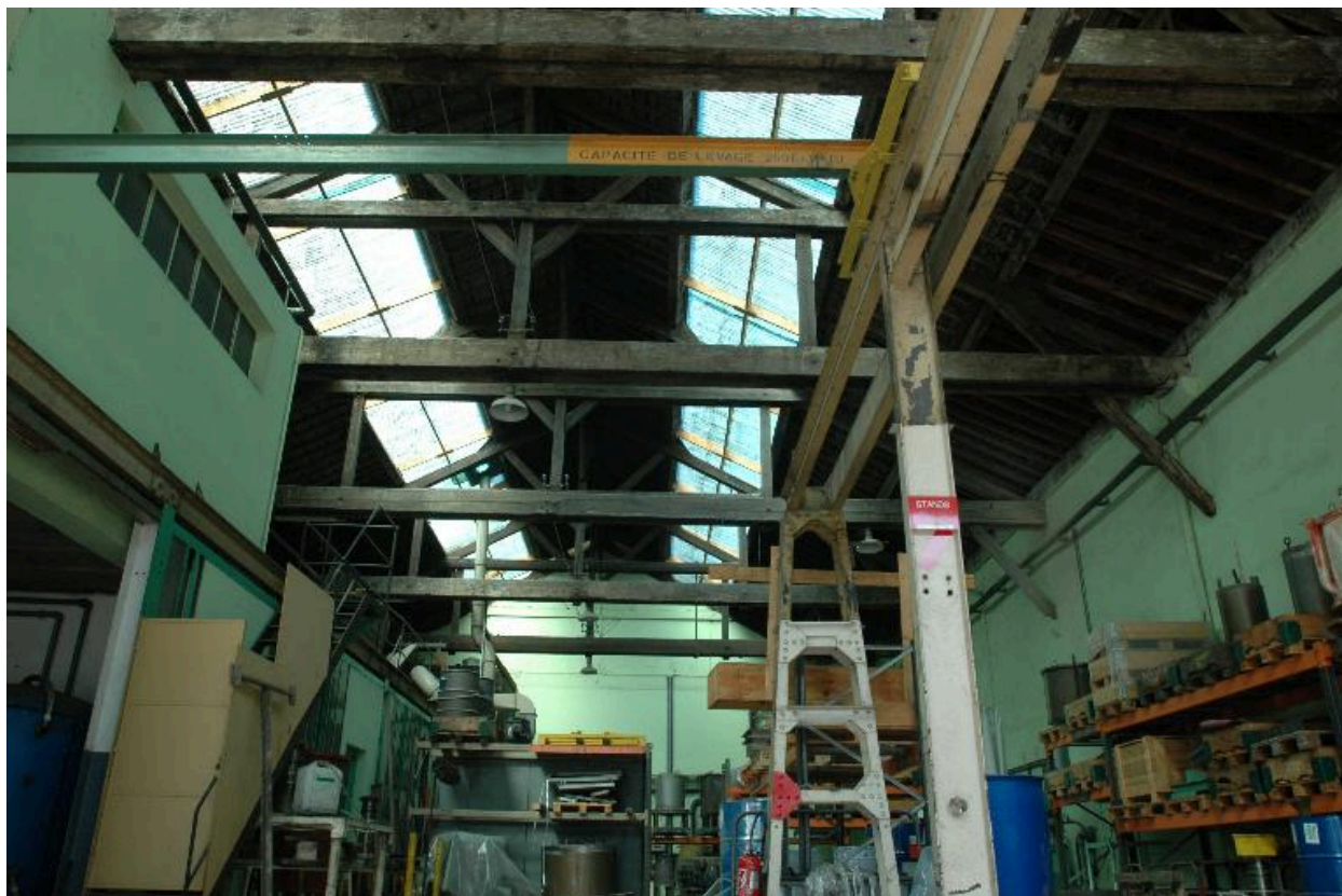
Détail de la charpente
