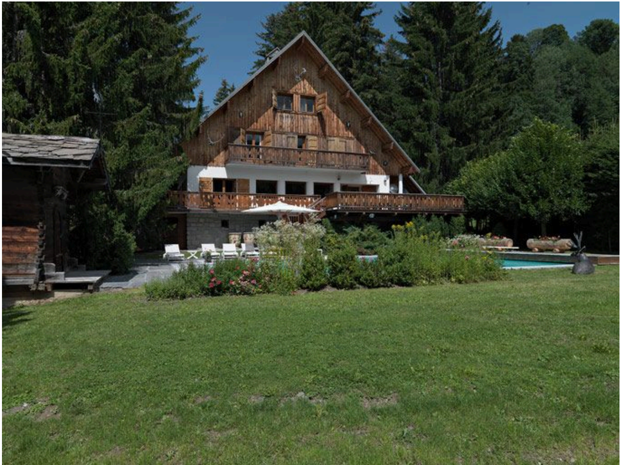
Vue générale depuis le sud
