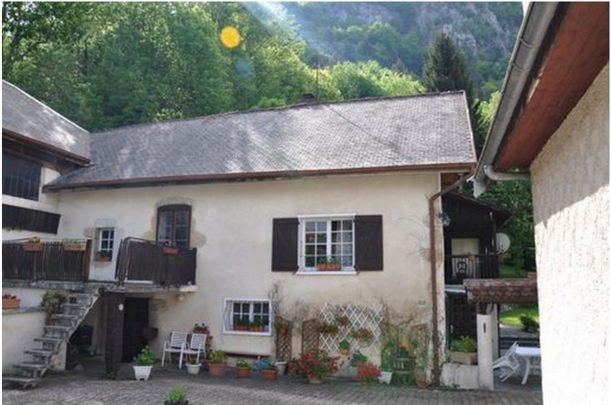
Façade antérieure du bâtiment du second moulin
