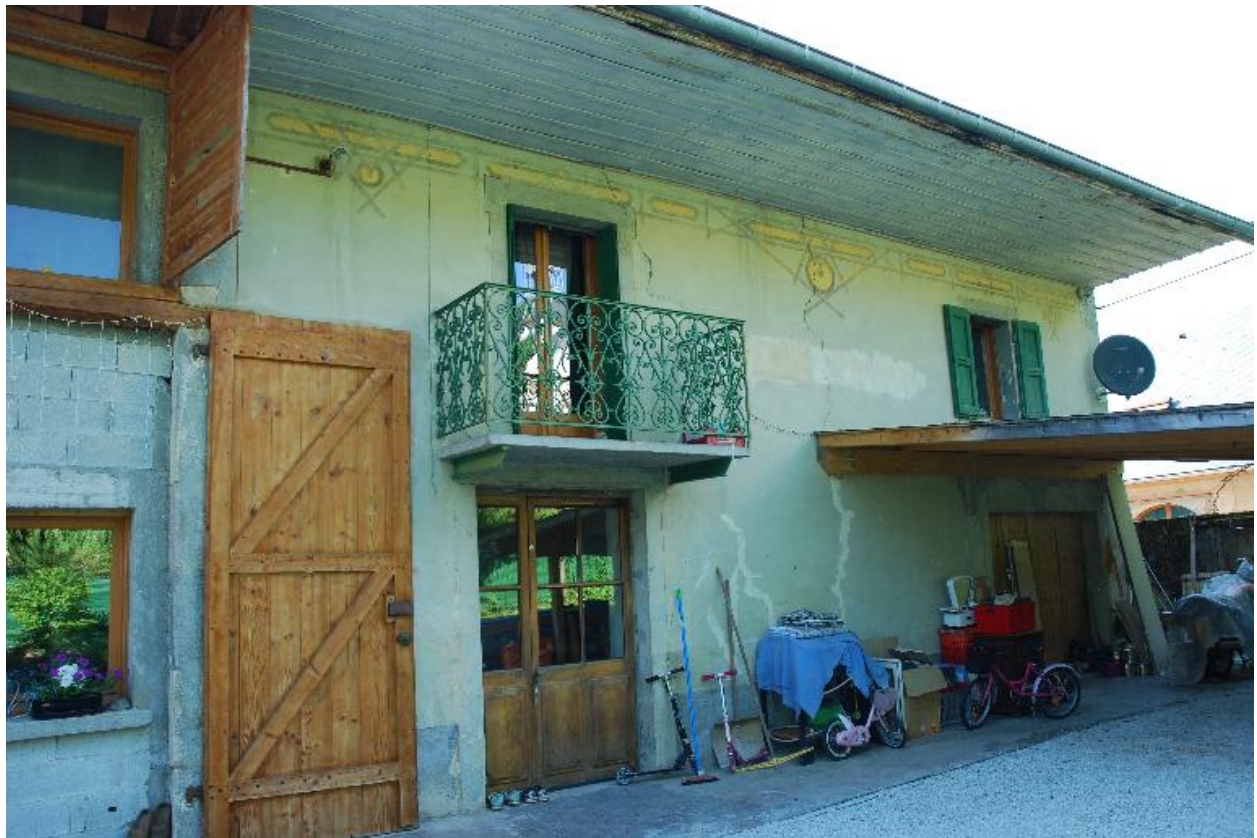
La Plesse, ferme (2013 D2 1041, partie), détail de la partie logis de la ferme.
