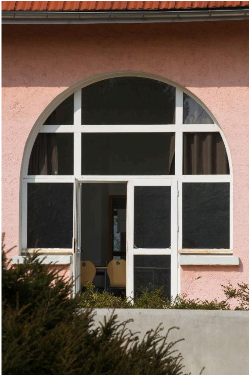
Bât. A : baie du couloir de distribution
