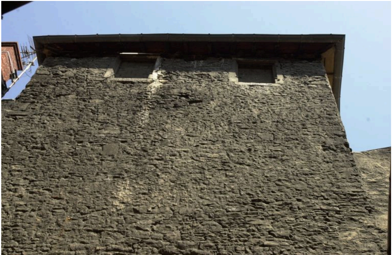
Pavillon d'escalier, partie haute, vu de l'immeuble voisin (27, rue Lanterne)
