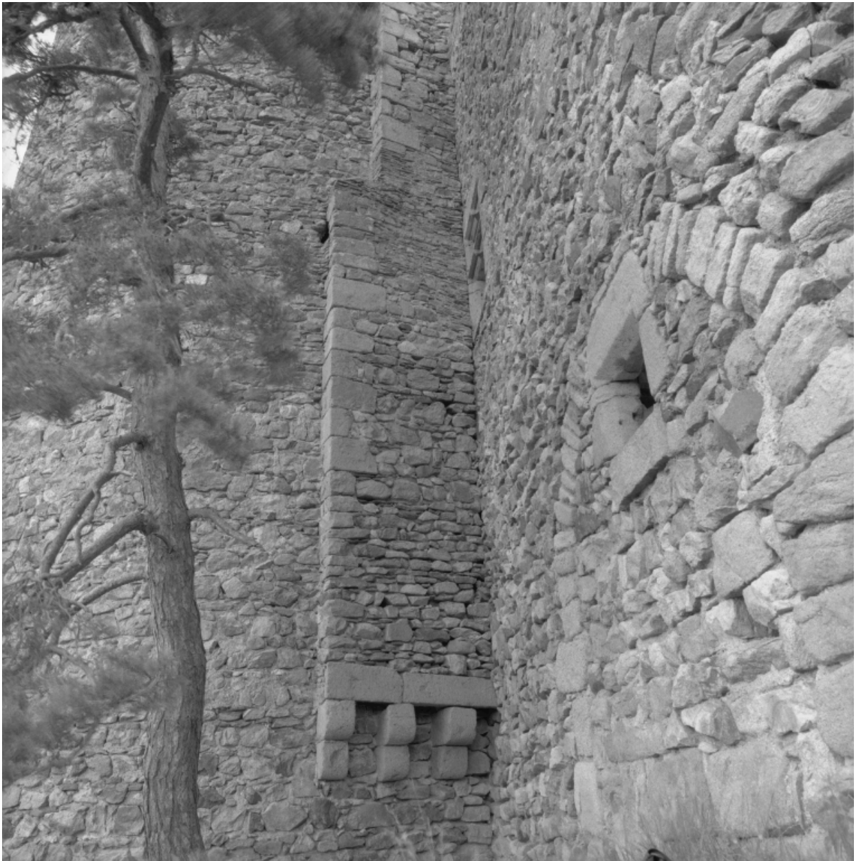
Troisième baie, château fort primitif, tour dite tour Saint-Antoine : détail extérieur du conduit des latrines, du sud-ouest.
