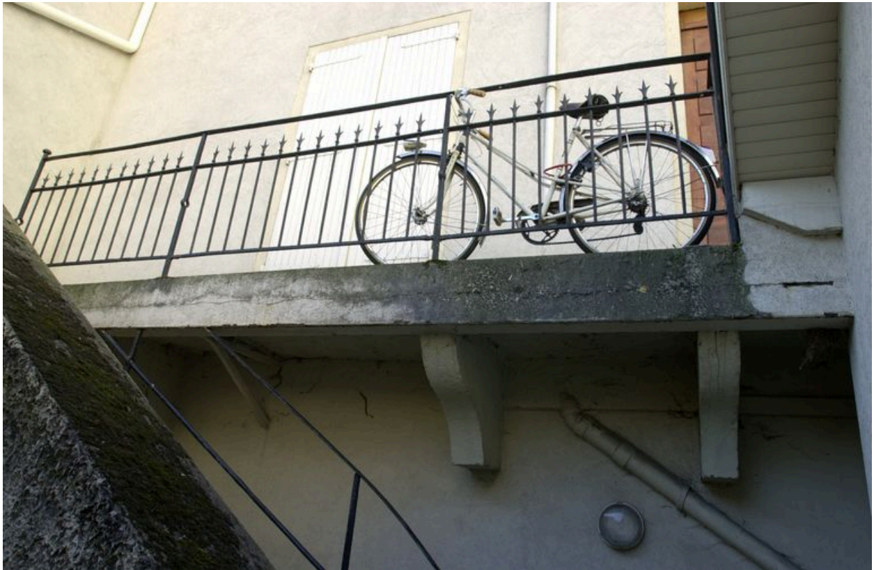
Elévation postérieure, détail de la coursière
