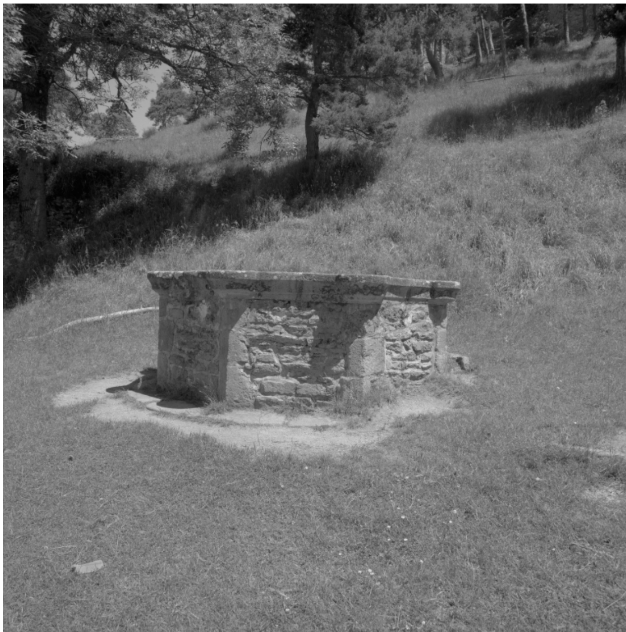
Premier baile, partie ouest du château- fort : détail du puits, du nord-ouest.
