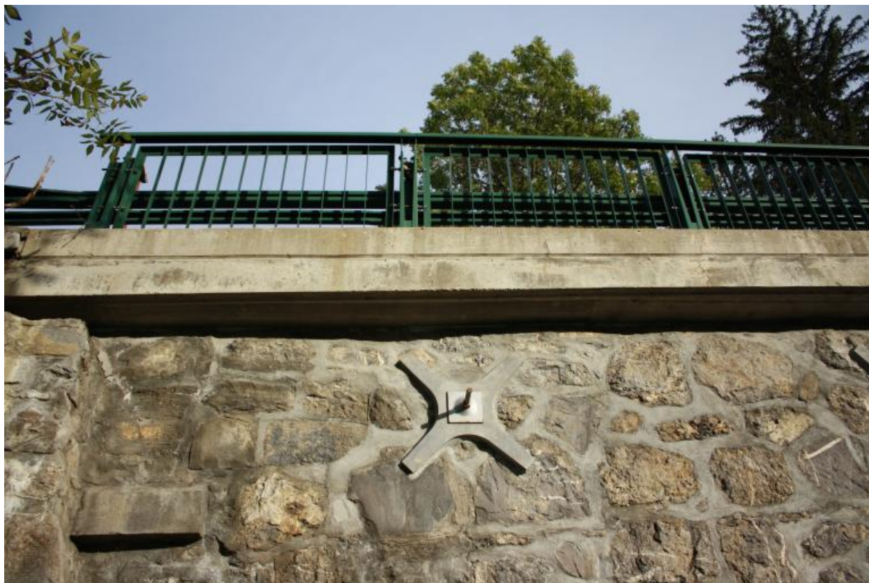
Pont de la Glières, détails tympan, enserrement et plinthe
