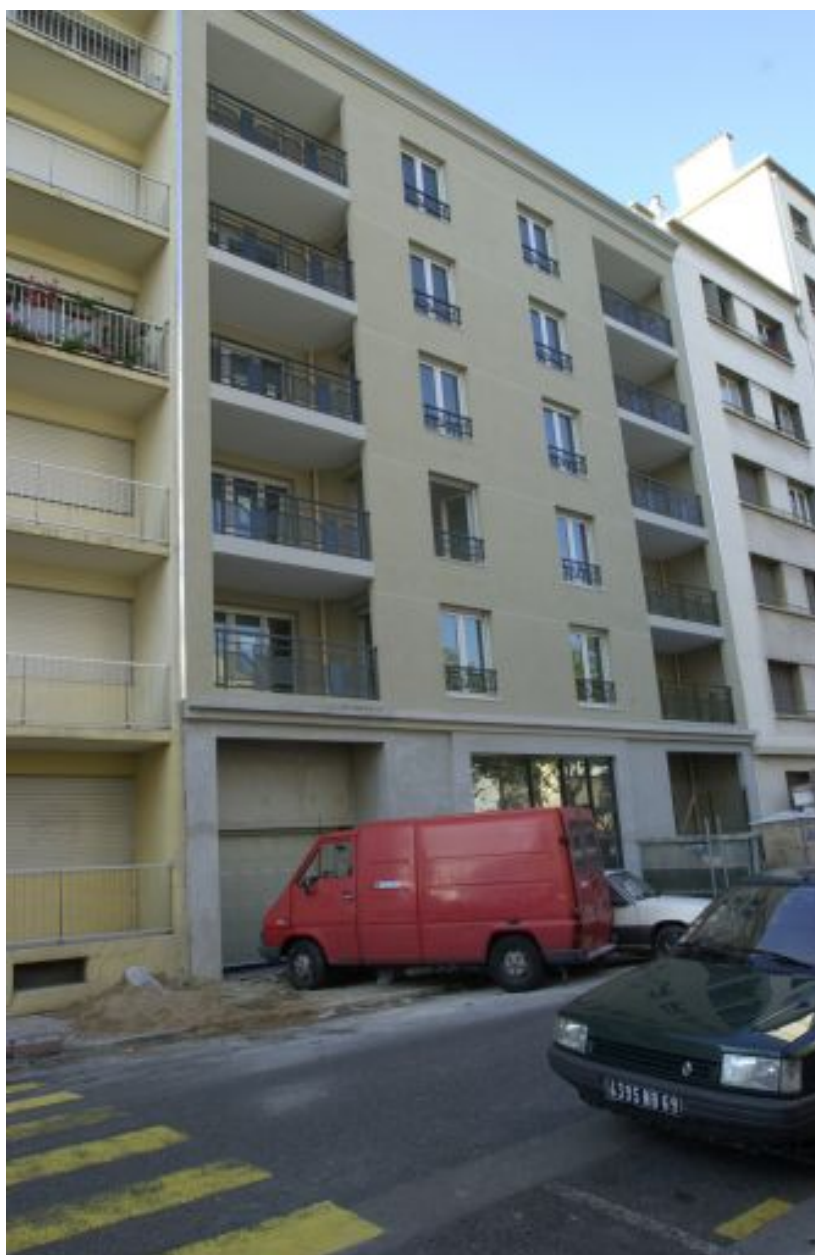
Vue générale, rue Delandine
