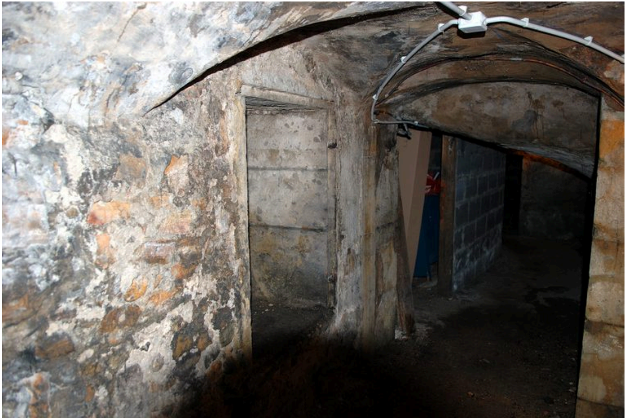
Vue partielle de la cave
