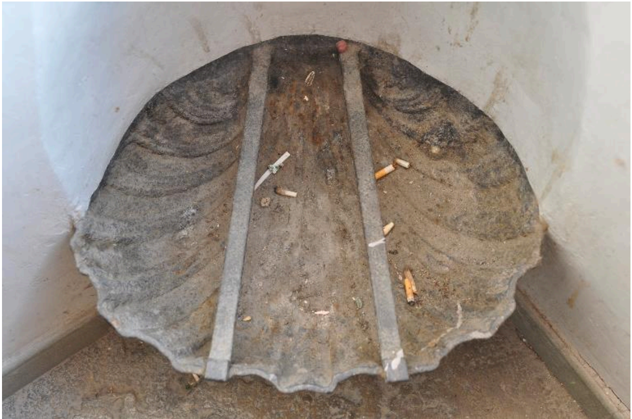
Vasque placée dans l'angle des repos de l'escalier
