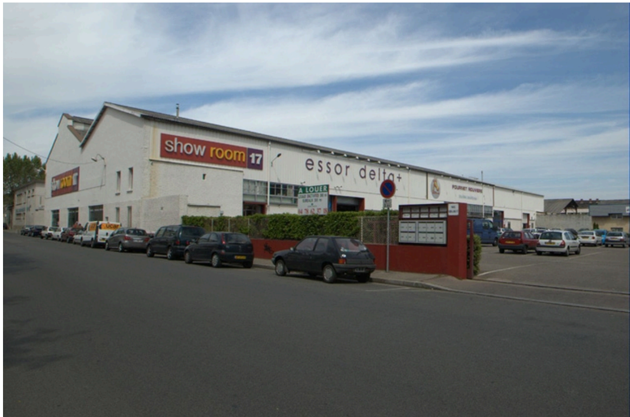
Vue d'ensemble sud-ouest
