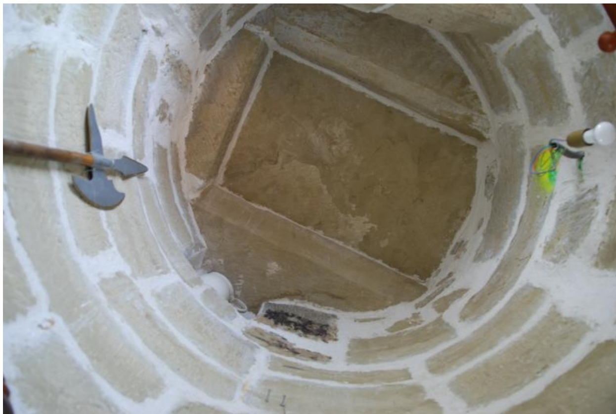
Etage de comble de la maison forte, tourelle d'angle nord, détail de la voûte plate.
